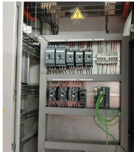
Autosoportado 2 m. Tablero de fuerza y control con variador de frecuencia.
